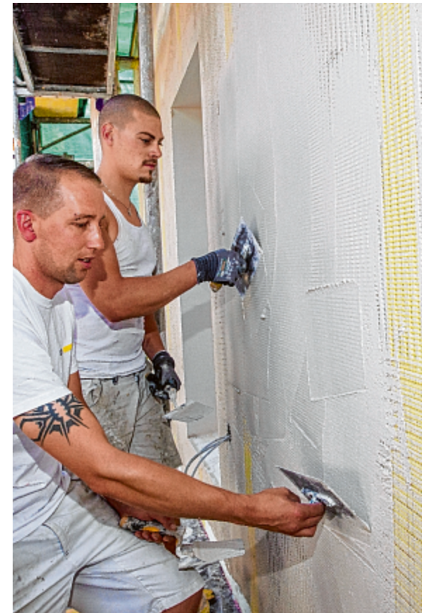
Jede kleinste Unebenheit der Styroporplatten gleicht Josef Lettenbichler mit dem Eisenhobel aus. Die Kontrolle erfolgt mittels Wasserwaage. Seit 2009 sind sie ein eingespieltes Team: Josef Lettenbichler und Stefan Höllwarth (Hintergrund) – hier beim Putzauftragen. Foto: Michael Kirsten
